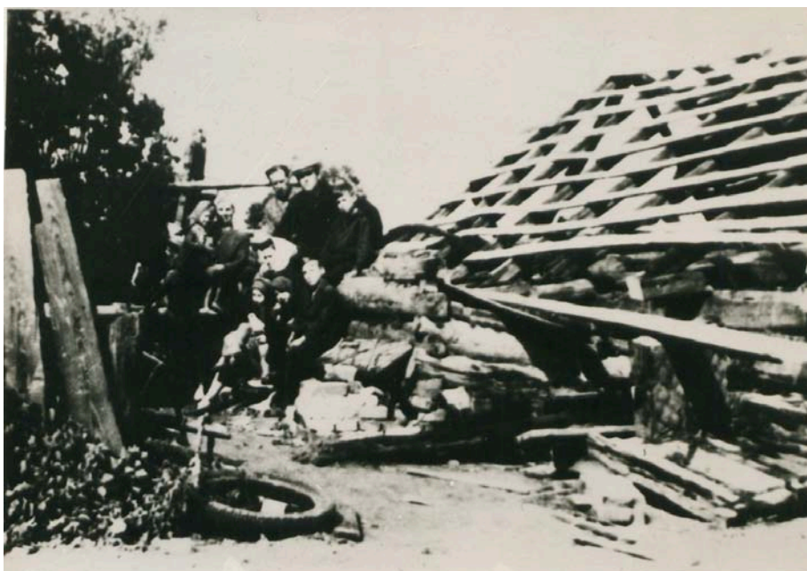
3. Разрушенный дом брата Дейнеги
